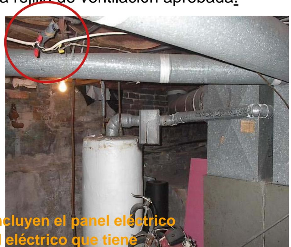
Situaciones peligrosas: incluyen el panel eléctrico que está abierto, el panel eléctrico que tiene fusibles muy altos, alambres eléctricos que han sido cortados impropriamente.
