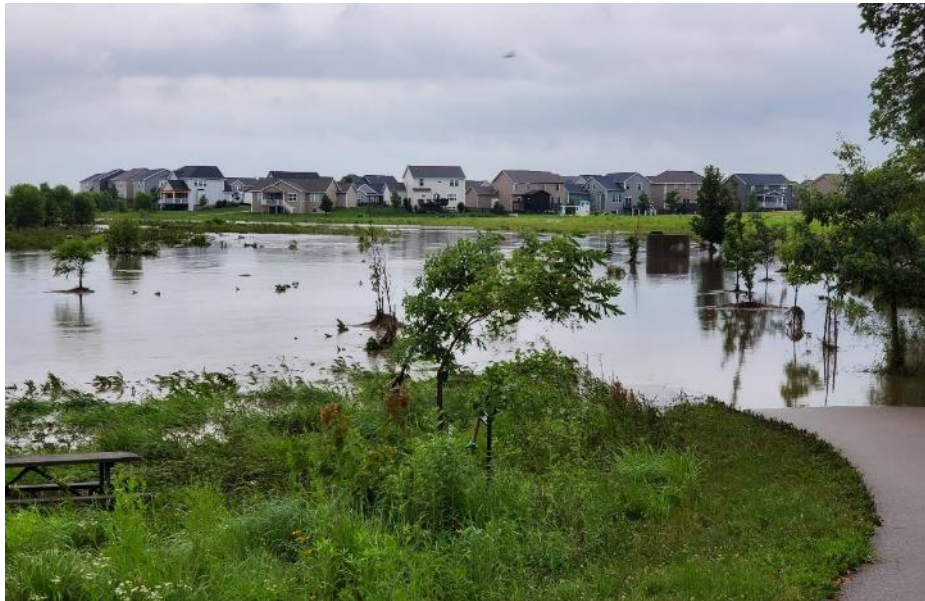
The Grove subdivision floodplain
