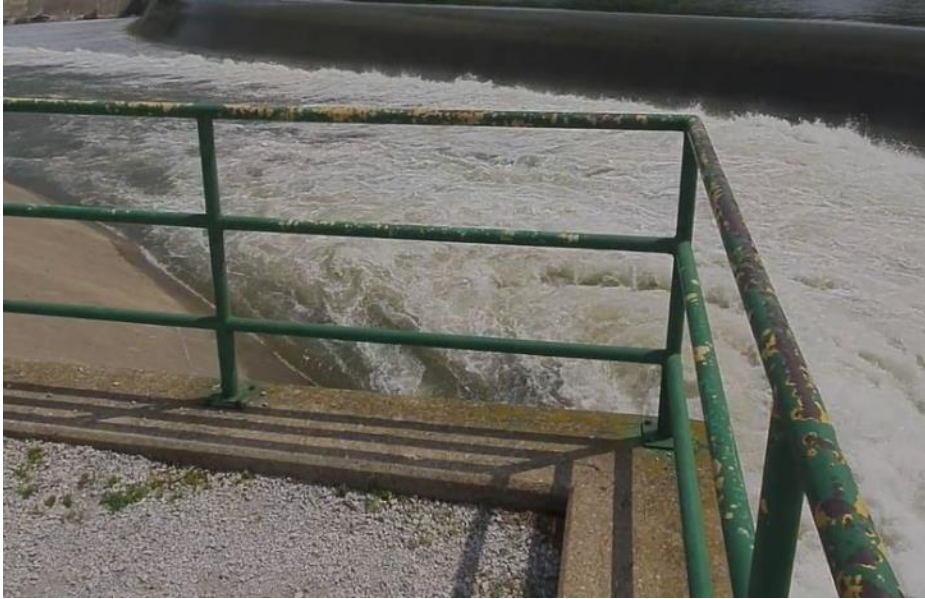
Lake Bloomington Spillway
